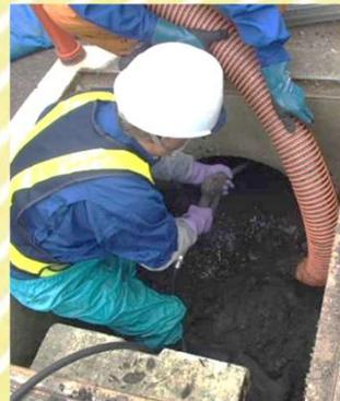
同日、色麻町立色麻学園様周辺の側溝・排水路内に堆積した土砂のかき出し作業及び吸引車を使用した抜取作業を加美営業所職員中心で実施いたしました(〜♪)
